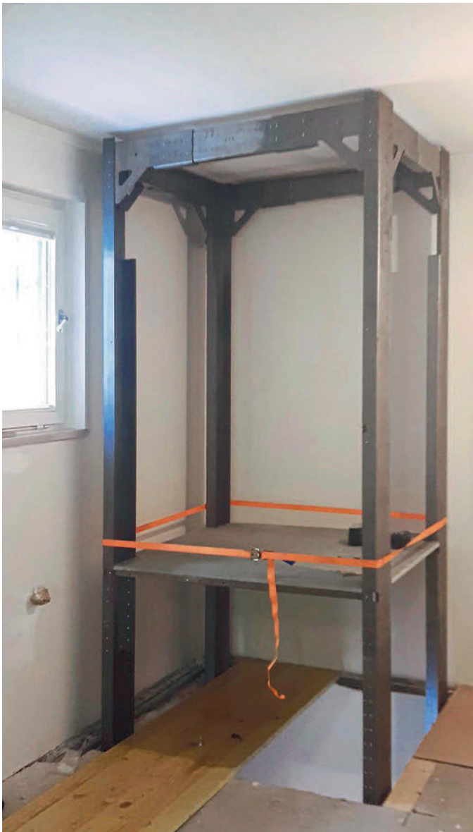
Situation im Obergeschoss: Die Grundkonstruktion aus Stahlprofilen ist auf die örtliche Begebenheit angepasst eingebaut
